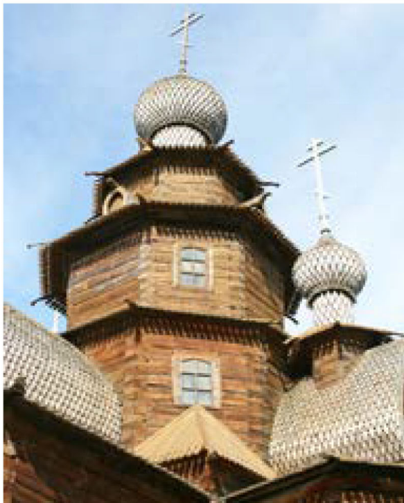
Ил. 73. Два яруса из трёх восьмериков, рубленных в косую лапу. Церковь Преображения Господня (1736) из села Козлятьево Кольчугинского района Владимирской области. Музей деревянного зодчества и крестьянского быта. Суздаль Владимирской области. Фото Владимира Грызлова
