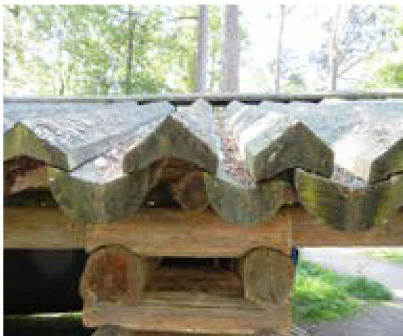
Ил. 69. Ветхая безгвоздевая тесовая крыша «в жёлоб» низкого сруба зимовки, пристроенной сбоку, с отступом от линии главного фасада дома А.Е. Болотовой (XIX– н. XX вв.) из деревни Королевская Нижне-Уфтюгского сельского совета Нюксенского района. Архитектурно-этнографический музей Вологодской области «Семёново». Фото из фондов музея
