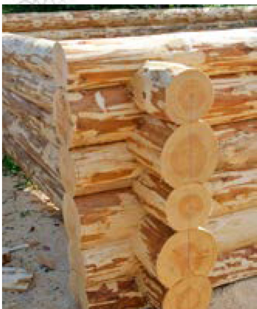
Ил. 78. Угол сруба бани из окоренного вручную бревна, рубленный в обло
