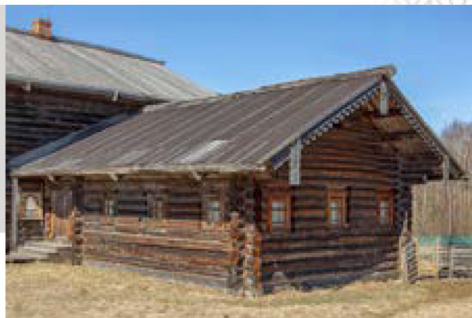
Ил. 69. Ветхая безгвоздевая тесовая крыша «в жёлоб» низкого сруба зимовки, пристроенной сбоку, с отступом от линии главного фасада дома А.Е. Болотовой (XIX– н. XX вв.) из деревни Королевская Нижне-Уфтюгского сельского совета Нюксенского района. Архитектурно-этнографический музей Вологодской области «Семёново». Фото из фондов музея
