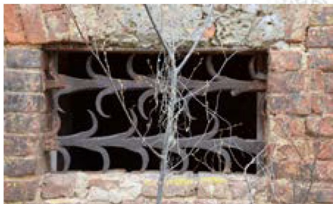
Ил. 85. Кованная оконная решётка с параллельными прутьями «в расщеп». Главный дом усадьбы (1819–1823) Барышниковых в деревне Алексино Дорогобужского района Смоленской области. Фото Светланы Меньшовой
